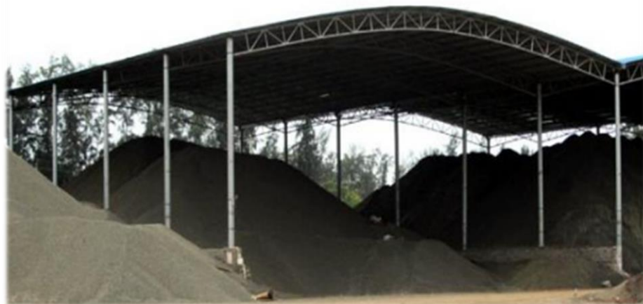
設置棚架遮擋
