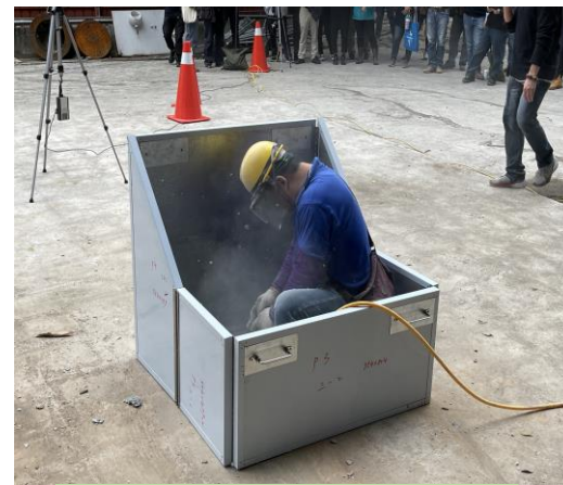
加強噪音防制設施
