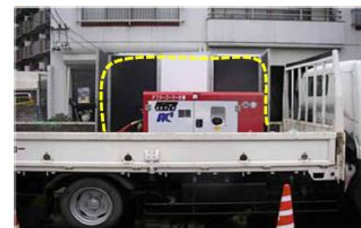
在緊鄰民宅處，架設U型吸隔音板圍隔
